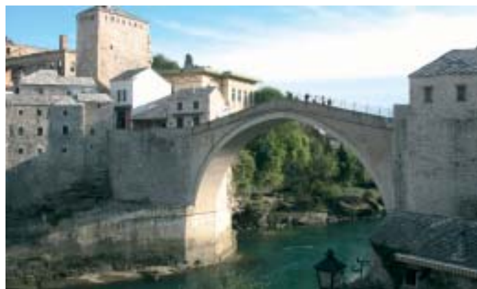
Il ricostruito ponte di Mostar
