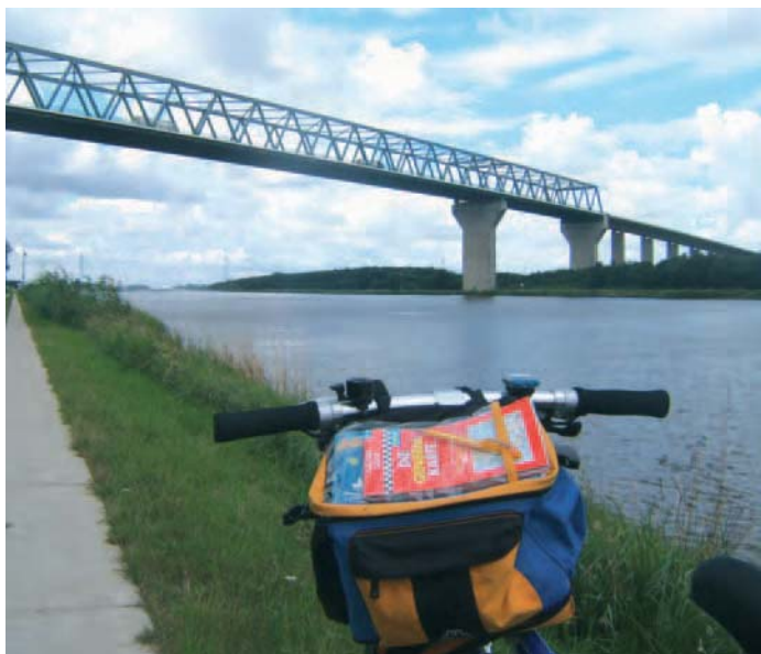
Il grande ponte metallico sulla ferrovia
